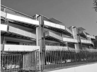
Sanierung MFH Grenchen ID | 15.08 ART | Sanierung & Umbau AUFTRAGSART | Direktauftrag BAUHERR | KATEGORIE | Wohnen ORT | Grenchen, SO JAHR | 2018 - 2019
