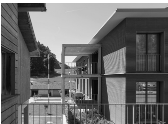
Karolinenheim Rumendingen Behindertenheim ID | 10.11 ART | Neubau, Erweiterung AUFTRAGSART | Studienauftrag 1. Preis KATEGORIE | Wohnen, Öffentliche Bauten BAUHERR | Stiftung Karolinenheim ORT | Rumendingen, BE BAUSUMME | 10,0 Mio JAHR | 2013 - 2015
